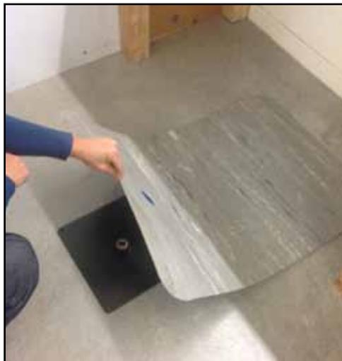
Placez le tapis antifatigue par-dessus la plaque. Le trou sur le tapis s'emboîte avec l'ancrage de la plaque au sol.
